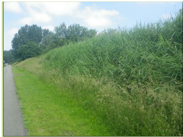
Talus de remblais colonisé par le Roseau commun (rive gauche)
