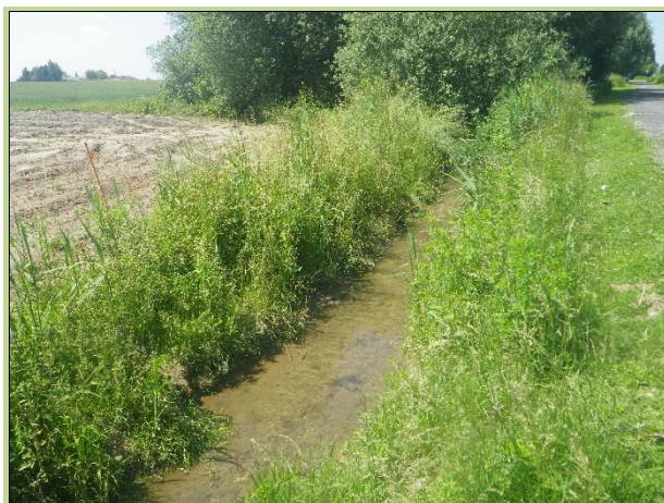
Fossé bordant le chemin de service (rive droite)
