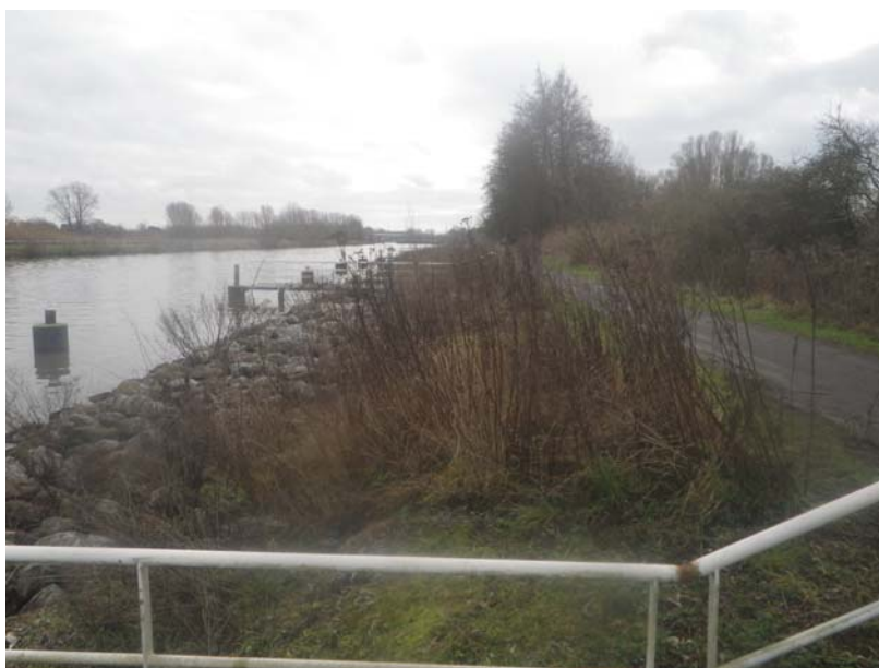
Vue sur le secteur concerné par l'allongement / réfection du poste d'attente amont
